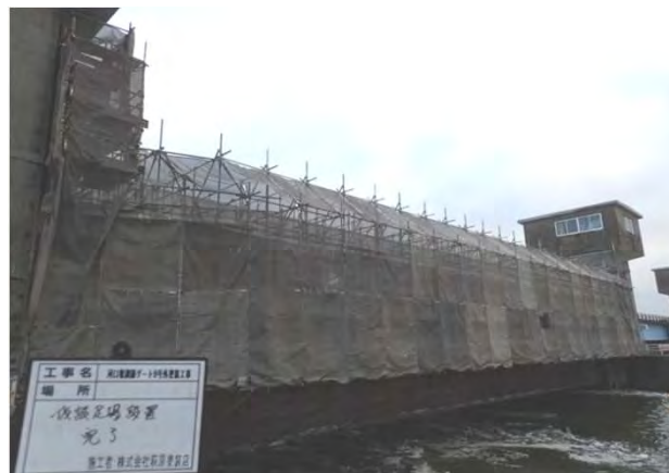
ゲート整備 (扉体・塗装・電気防食)
