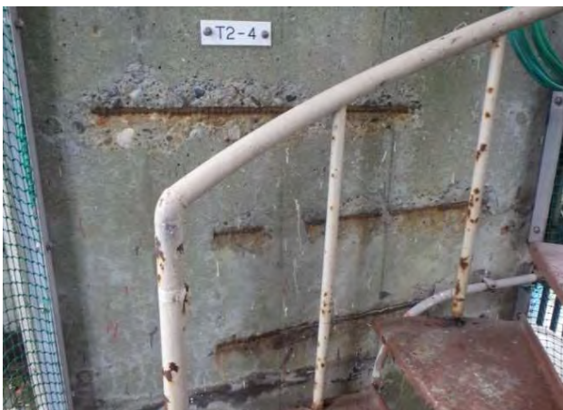
堰柱内鉄筋露出状況
