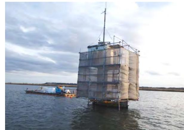
水上観測局舎整備
