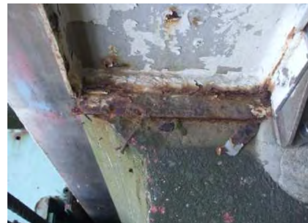
制水ゲート戸当り塗装腐食状況
