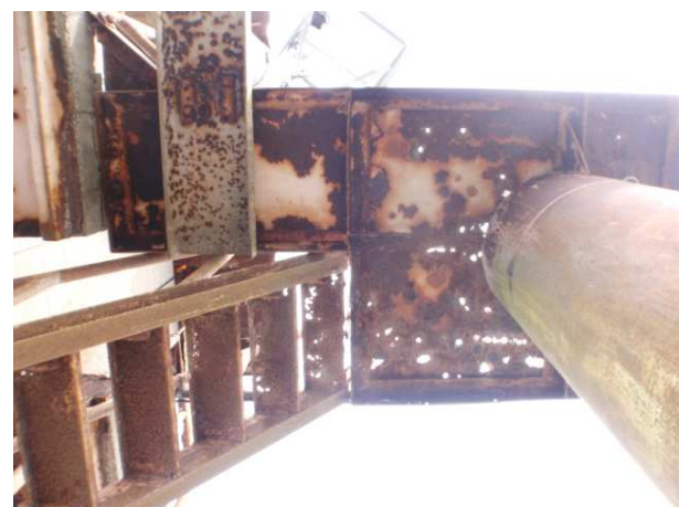
観測局舎踊場・階段腐食状況
