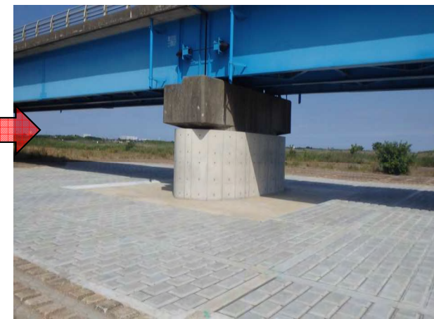
利根川大橋P1橋脚工事完成
