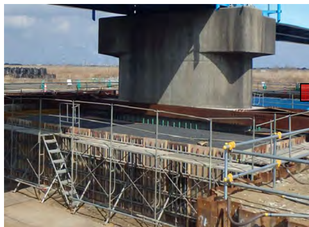
利根川大橋P1橋脚工事状況
