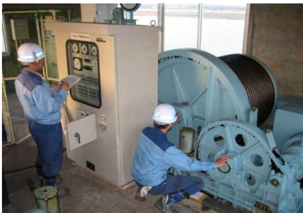
職員によるゲート設備の点検
