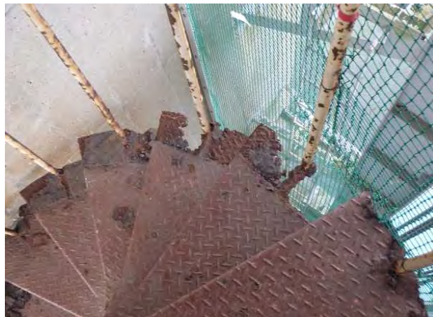
堰柱螺旋階段腐食状況
