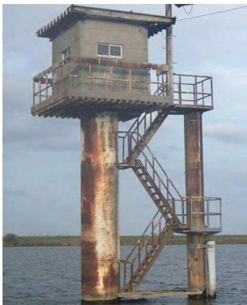
観測局舎発錆出状況
