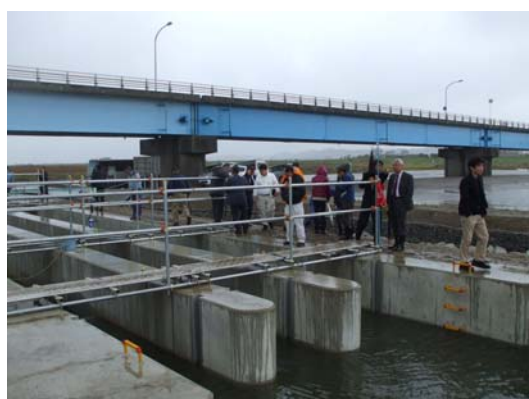
改築された右岸魚道
