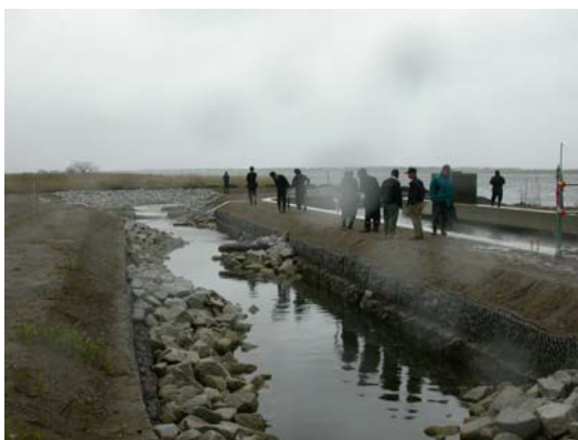
新たに設けられた多自然魚道
