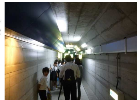
ダム内部通路
