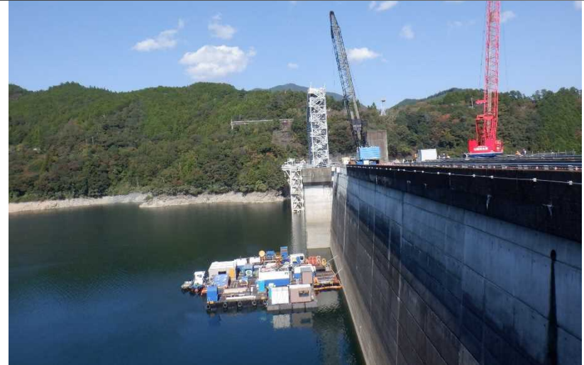
潜水台船搬入状況（全景）
