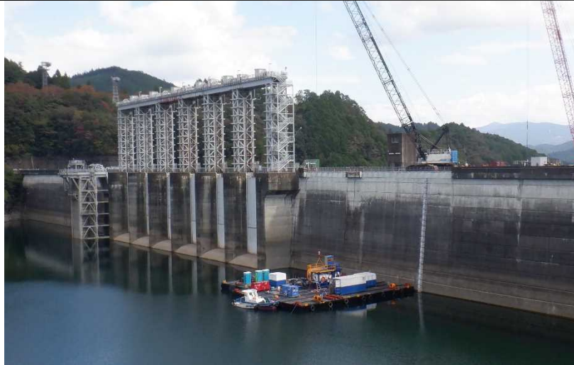
120tクローラクレーンによる搬入
