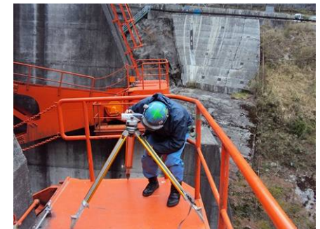
トラニオン軸仮センター標高の計測状況
