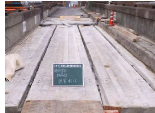
鉄筋計設置状況
