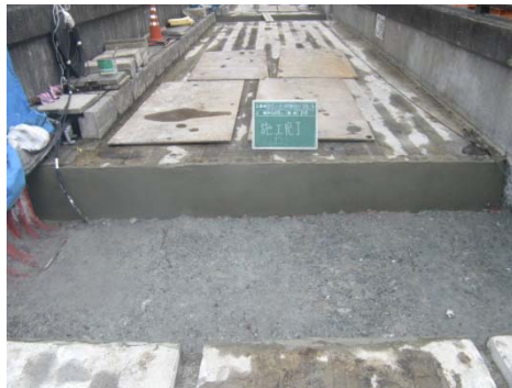
断面補修工完了状況
