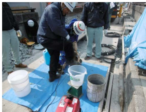
無収縮グラウト現場練り状況
