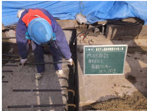
鉄筋設置状況
