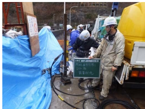
機械ボーリング削孔状況
