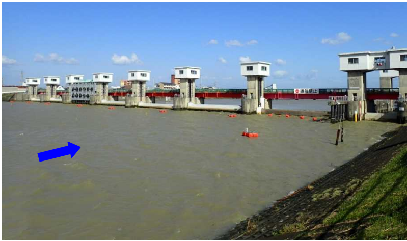
平常時操作中の今切川河口堰（上流側より撮影）
