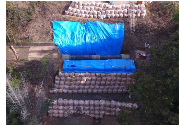
鋼管布設状況
