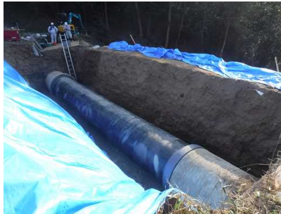
鋼管布設状況(φ1500mm)
