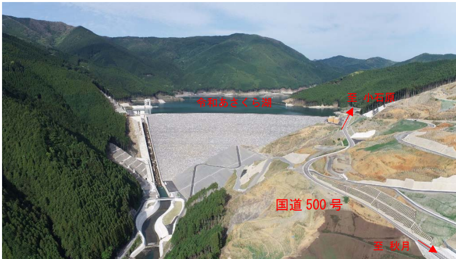
小石原川ダム
