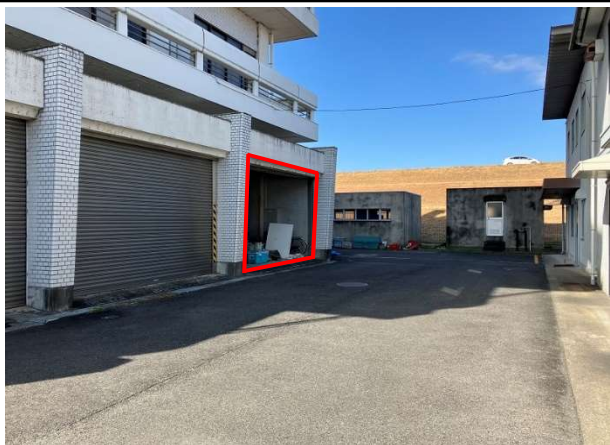
保管建屋（車庫）
