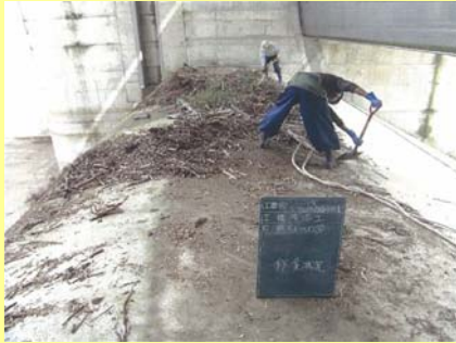
洪水吐きゲート越流部 塵芥の集積状況
