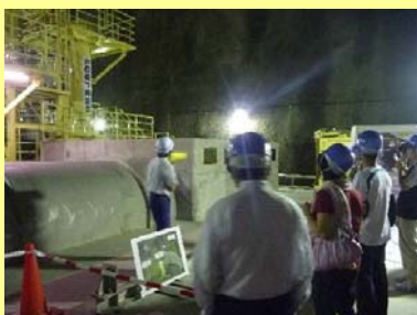
堤体内案内(ゲート室)
