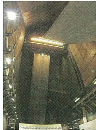
中空重力式コンクリートダムの内部空間
