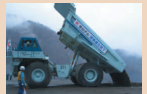
▲徳山ダム堤体盛立完了
