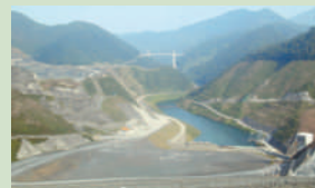
▲徳山ダム試験湛水開始(平成18年9月)
