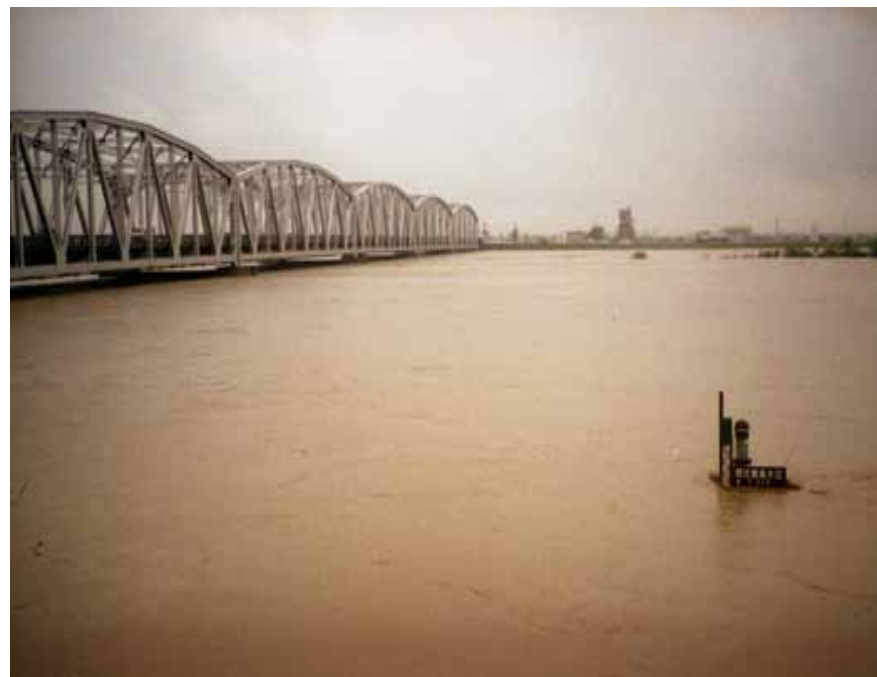
万石地点(揖斐大橋)の状況(H14.7)
