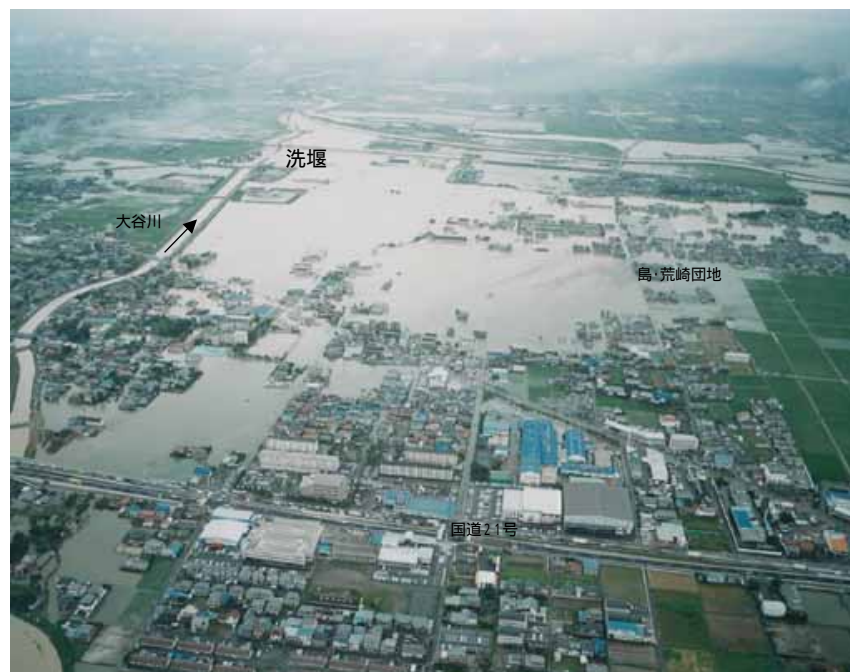
台風23号による被災状況(H16.10)
