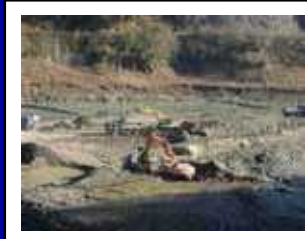
堆積土砂除去作業
