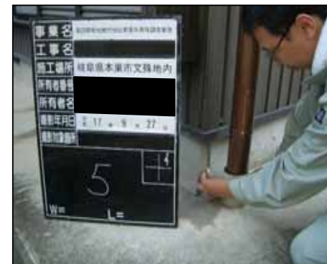
家屋基礎のレベル調査
