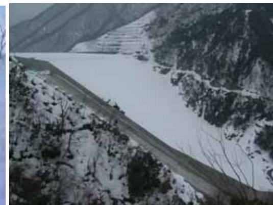
堤体及び洪水吐き
