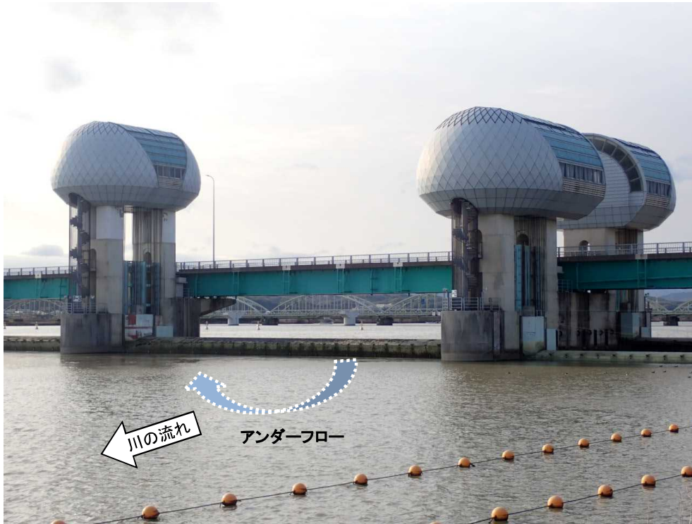
堰下流側 アンダーフロー操作に切り替え
