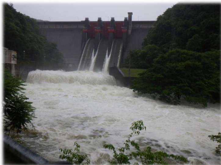
令和5年6月2日 台風2号時のゲート放流状況
