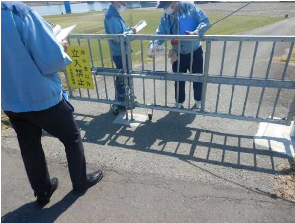
右岸側侵入防止施設の確認状況
