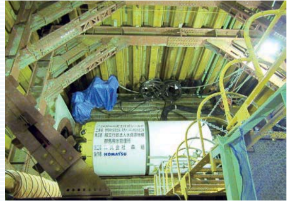
発進立坑内設置
