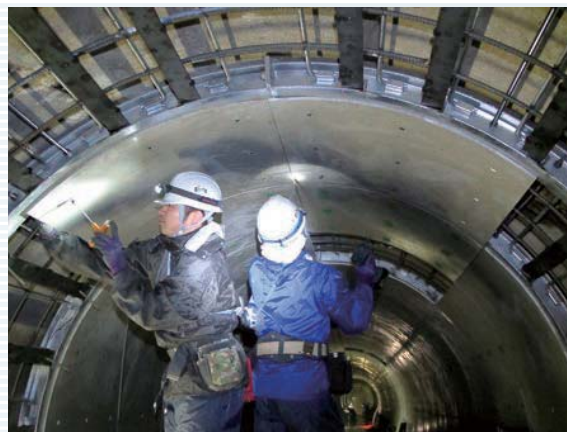
樹脂パネル設置中
