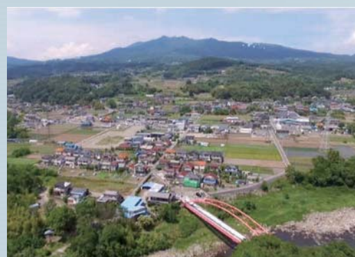
吾妻川水管橋
