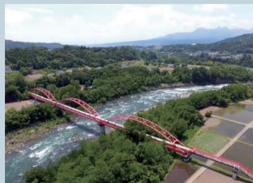
利根川水管橋
