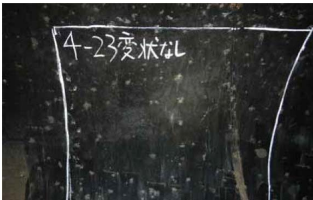
鋼管の内面を目視により確認を行う。
