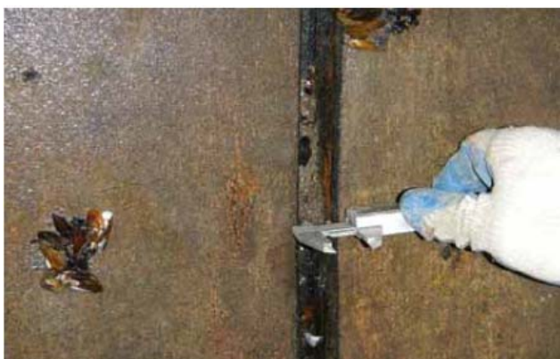
ダクタイル鋳鉄管のつなぎ目の間隔を確認。
