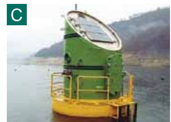
水質自動監視装置（たけのこ） 水温、pH、濁度、溶存酸素電気伝導度クロロフィルaを毎正時計測しています。
