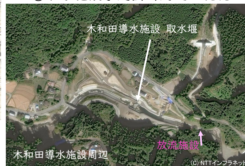
②放流施設予定箇所周辺の現況
