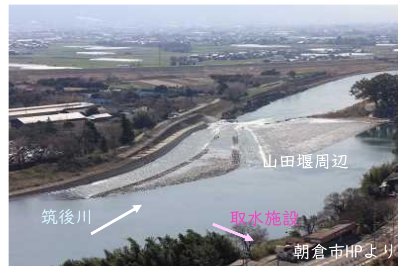
①取水施設予定箇所周辺の現況
