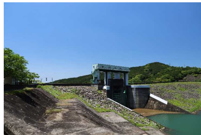
左岸側からのゲート方向の状況 47
