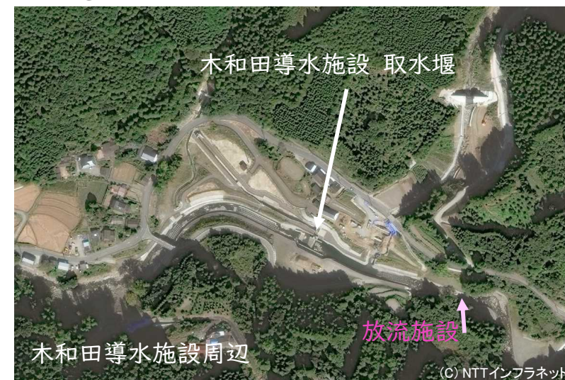
②放流施設予定箇所周辺の現況
