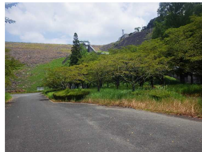
寺内ダム下流広場の状況①
