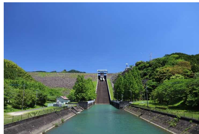
下流側からのゲート方向の状況
