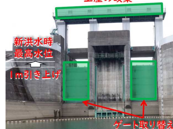
非常用洪水吐きの改造 上屋の改築
