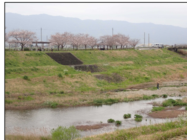
左岸側の公園の様子
