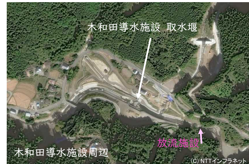
②放流施設予定箇所周辺の現況
