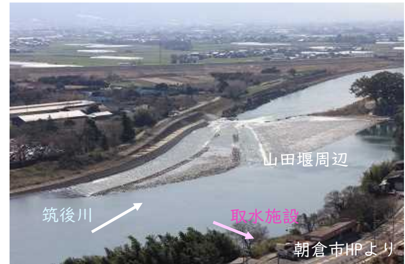
①取水施設予定箇所周辺の現況
