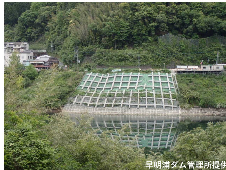
地すべり対策工事イメージ
