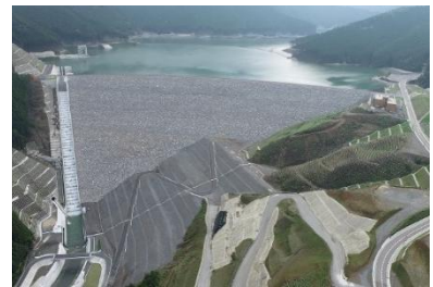
小石原川ダム
