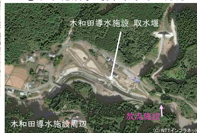
②放流施設予定箇所周辺の現況
