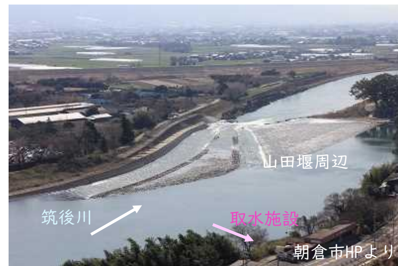
①取水施設予定箇所周辺の現況
