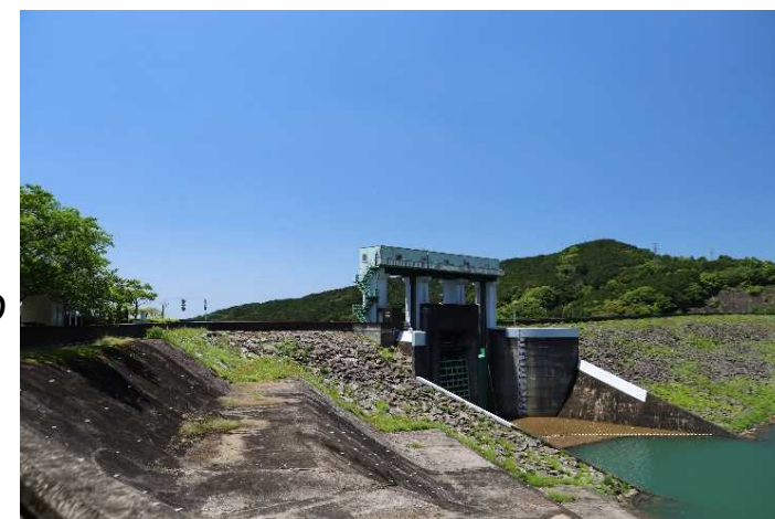
左岸側からのゲート方向の状況 47
