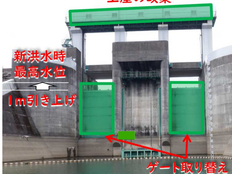
非常用洪水吐きゲートの工事の内容
