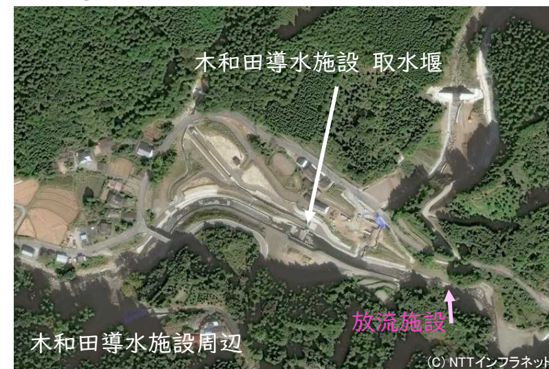
②放流施設予定箇所周辺の現況
