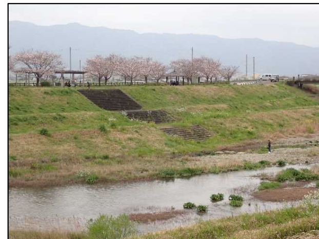
左岸側の公園の様子
