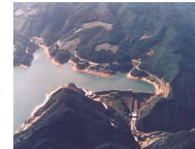
江川ダム (水機構)
