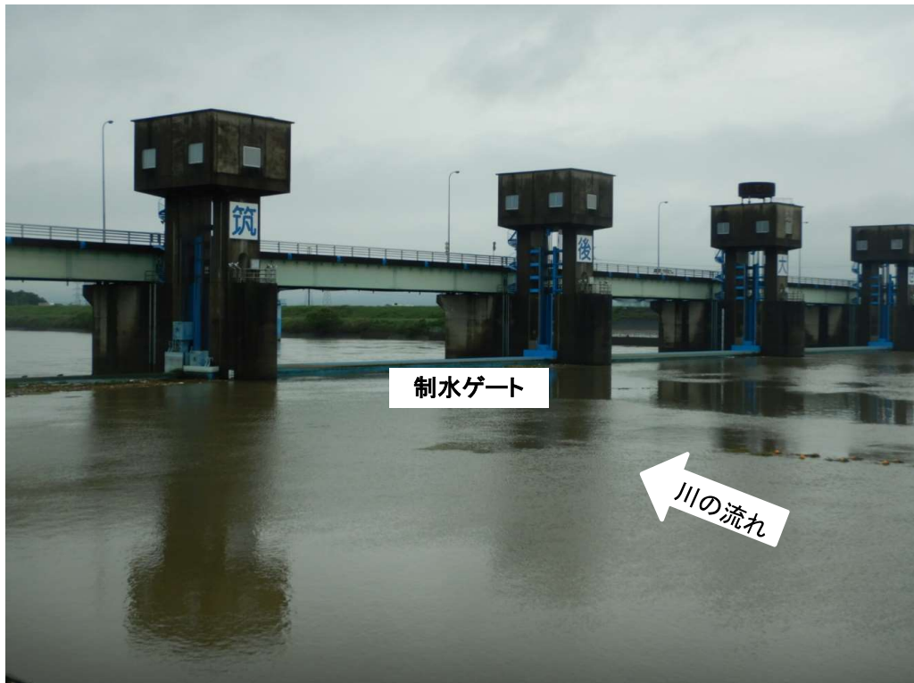
ゲート全開操作終了後の筑後大堰（堰上流側から望む）
