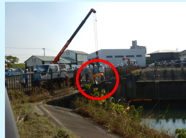
クレーンを使用した 高所からのポンプ投入
