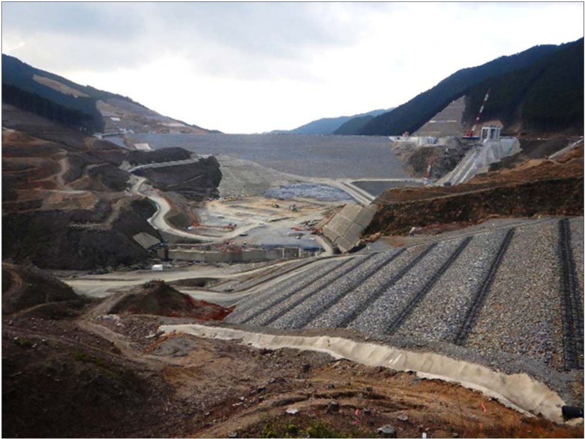
試験湛水開始時点（12月14日） 上流から小石原川ダム堤体を望む
