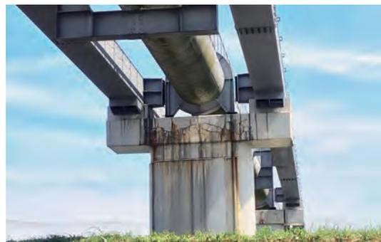
思案橋水管橋下部工のひび割れ
