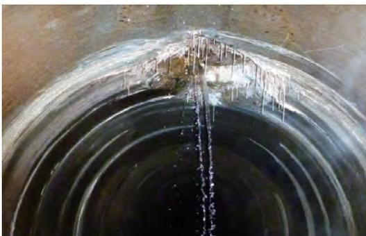
トンネル頂部の欠損
