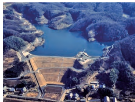
はちや 木曽川用水（蜂屋調整池）
