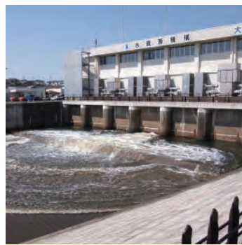
印旛沼開発（大和田機場）
