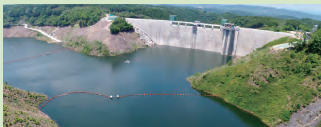
試験湛水中の川上ダムの様子
