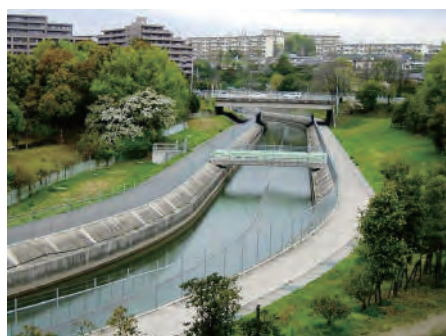
はくせん 愛知用水二期（白山開水路）
