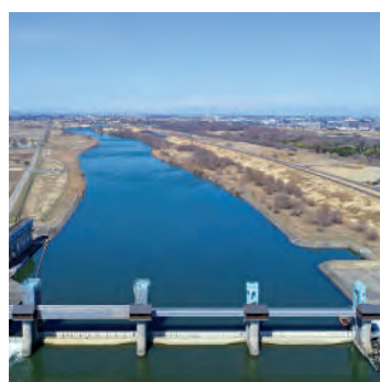
利根導水路大規模地震対策（秋ヶ瀬取水堰）
