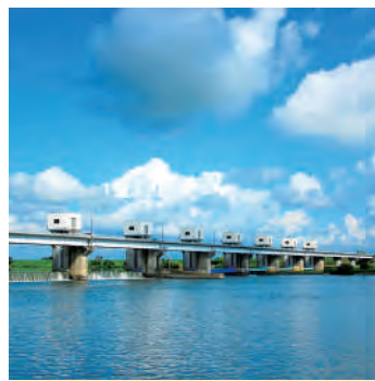
利根導水路（利根大堰）
