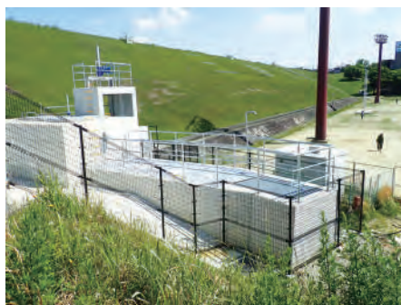
愛知用水三好支線水路緊急対策
