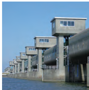
利根川河口堰
