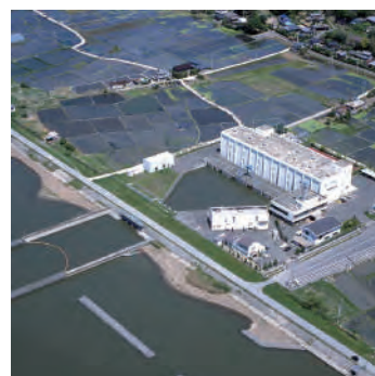
霞ヶ浦用水（揚水機場）
