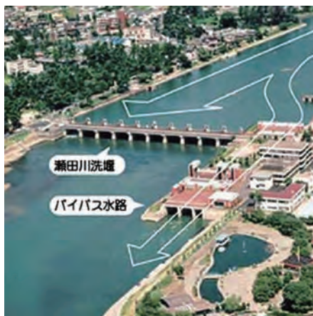
琵琶湖開発 (瀬田川洗堰バイパス水路)
