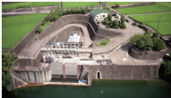
香川用水（取水工）
