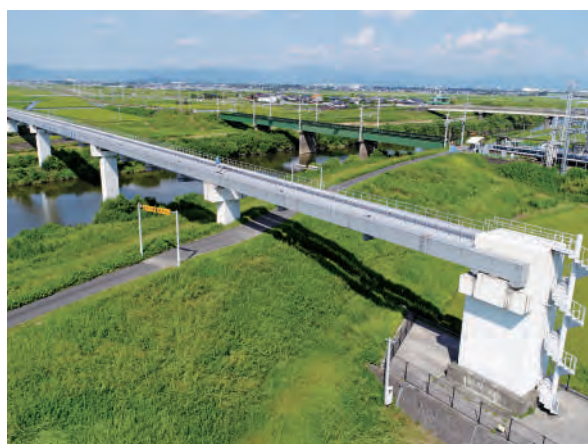
福岡導水施設地震対策
