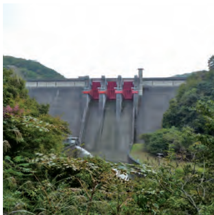
室生ダム (室生湖)
