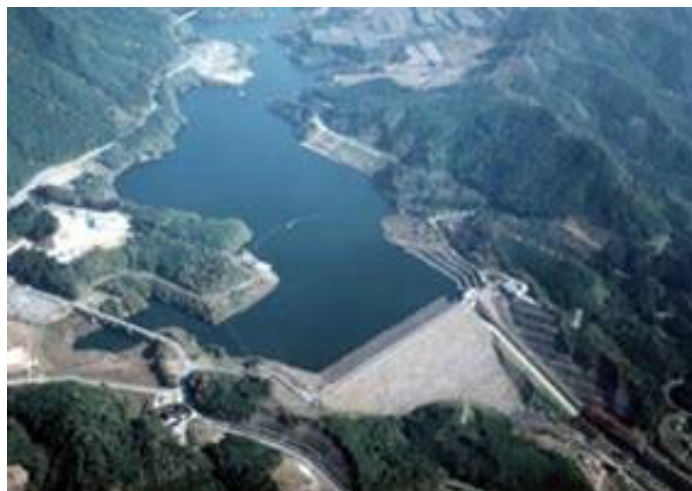
【寺内ダム管理所】 福岡県朝倉市荷原1516-6
