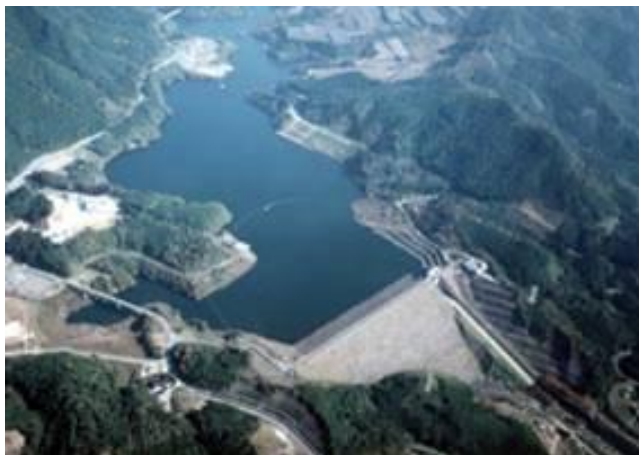
【寺内ダム管理所】 福岡県朝倉市荷原1516-6
