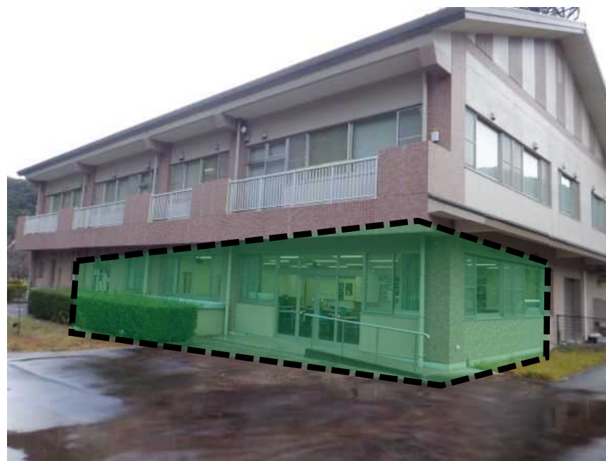
管理所外観（枠内：利用可能エリア）
