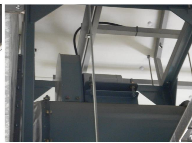
排気ファン電動機取付状況写真
