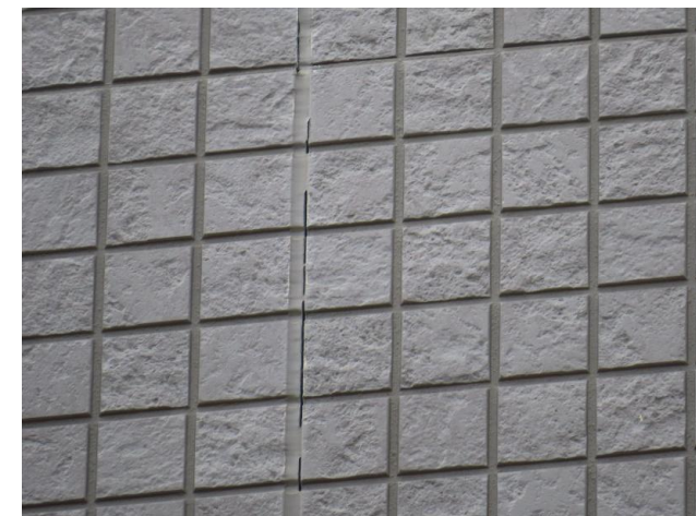
破断部拡大(3)
