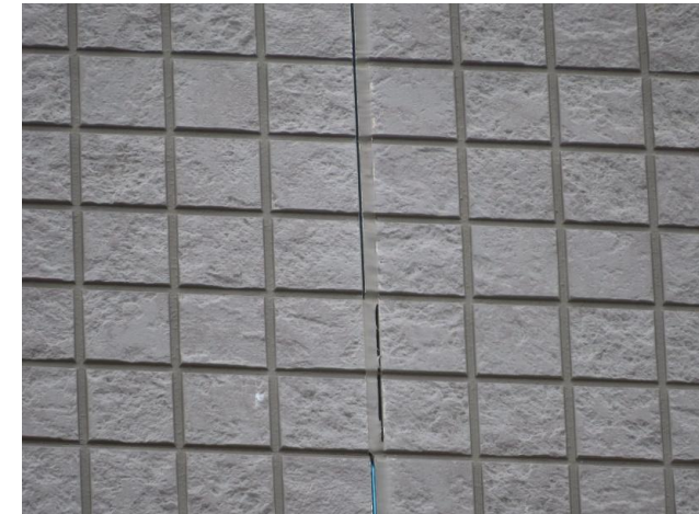
破断部拡大(2)
