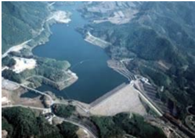
【寺内ダム管理所】 福岡県朝倉市荷原1516-6
