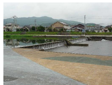
あまぎばしどうしゅこう 甘木橋頭首工
