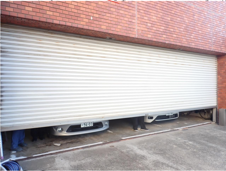
シャッター更新改修場所 現況写真
