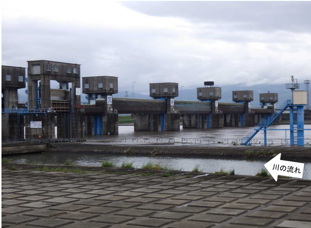
ゲート全開操作開始後の筑後大堰 (左岸堰上流側から堰を望む)
