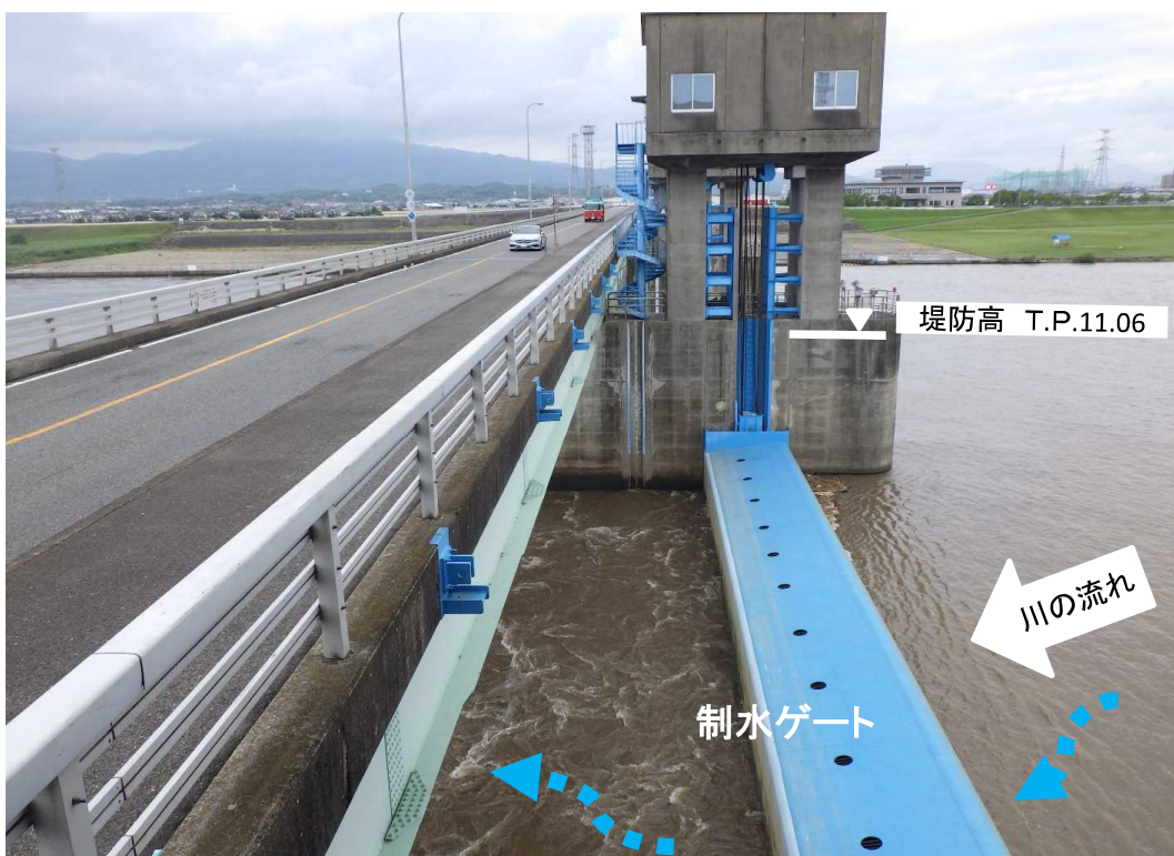
ゲート全開操作終了後の筑後大堰 5月21日10時撮影 (1号制水ゲートを左岸から右岸に向かって望む)
