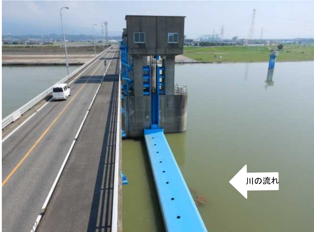
1号制水ゲートを左岸から右岸に向かって望む
