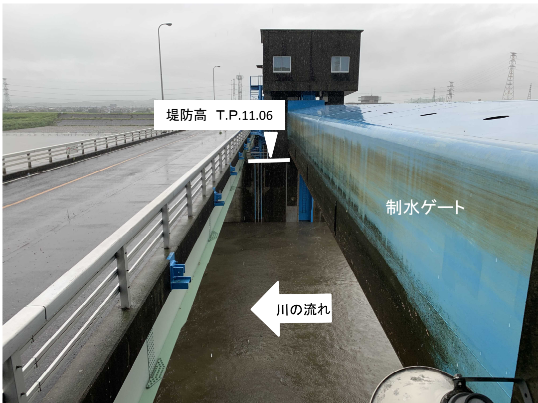
ゲート全開操作開始直後の筑後大堰 8月12日13時撮影 (1号制水ゲートを左岸から右岸に向かって望む)
