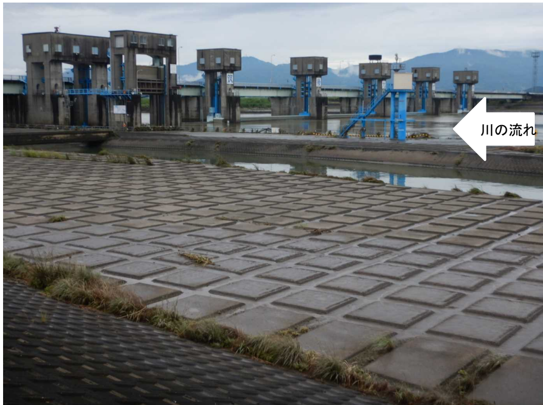
ゲート全開操作終了後の筑後大堰 8月16日9時撮影 (左岸堰上流側から堰を望む)
