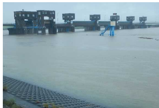
ゲート全開操作時の筑後大堰 （上流から下流を望む） 令和3年8月13日9時撮影 （堰地点水位 T.P. +5.75m）
