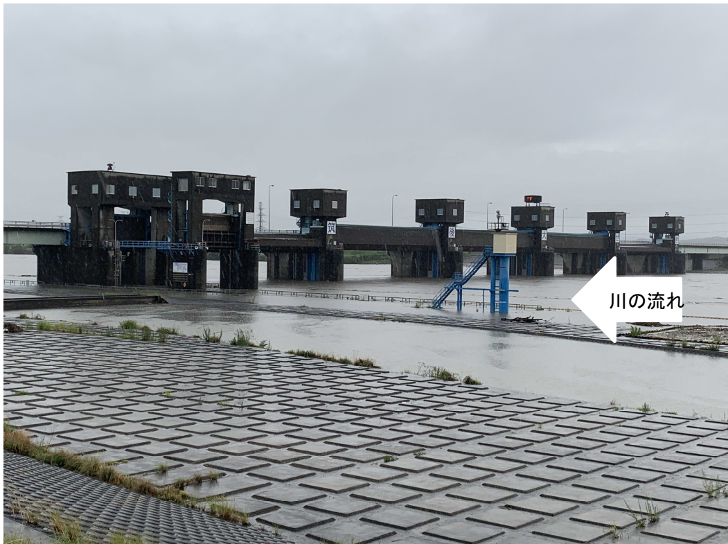
ゲート全開操作開始直後の筑後大堰 8月12日13時撮影 (左岸堰上流側から堰を望む)
