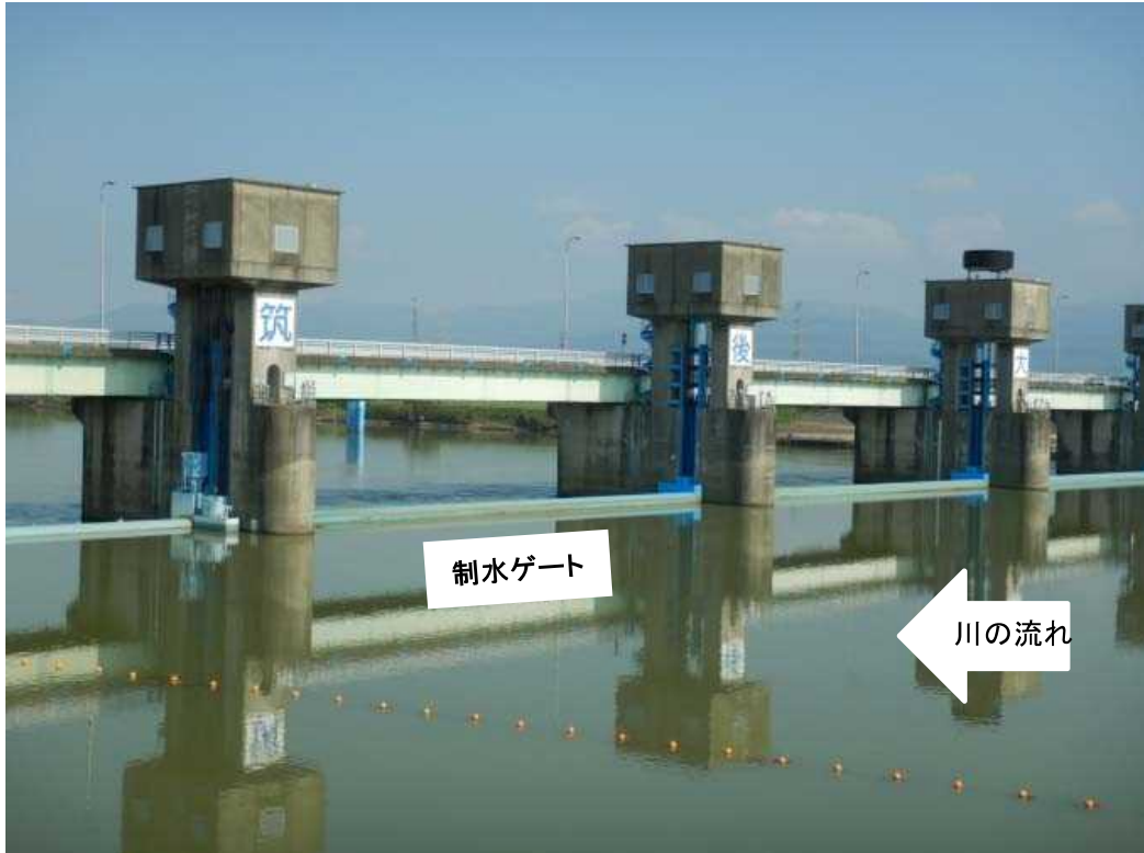
左岸上流側から筑後大堰を望む 洪水時のゲート状態(ゲート全開)
