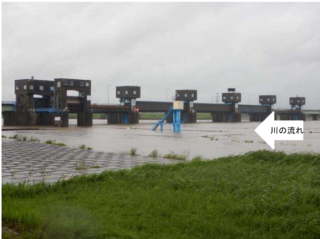
ゲート全開操作開始直後了の筑後大堰 7月19日9時撮影 (左岸堰上流側から堰を望む)
