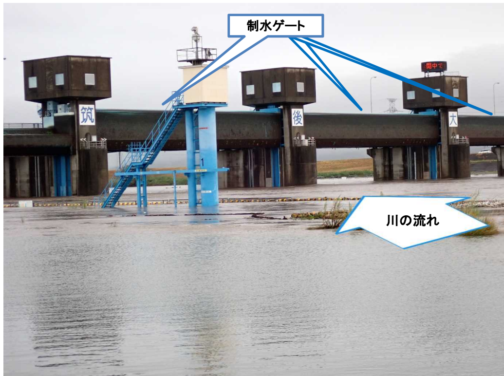
ゲート全開操作開始後の筑後大堰
