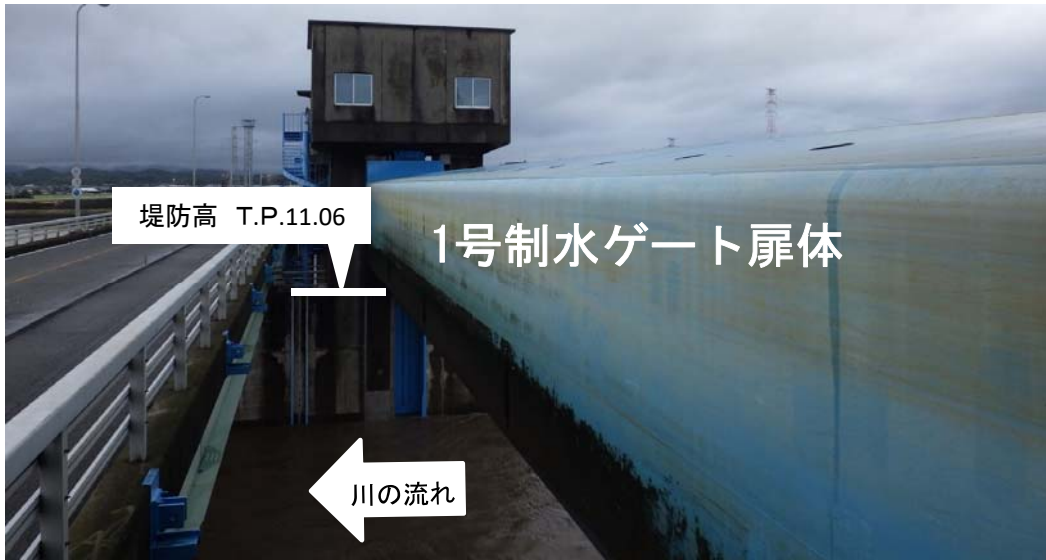
ゲート全開操作開始後の筑後大堰 (1号制水ゲートを左岸から右岸方向に望む)
