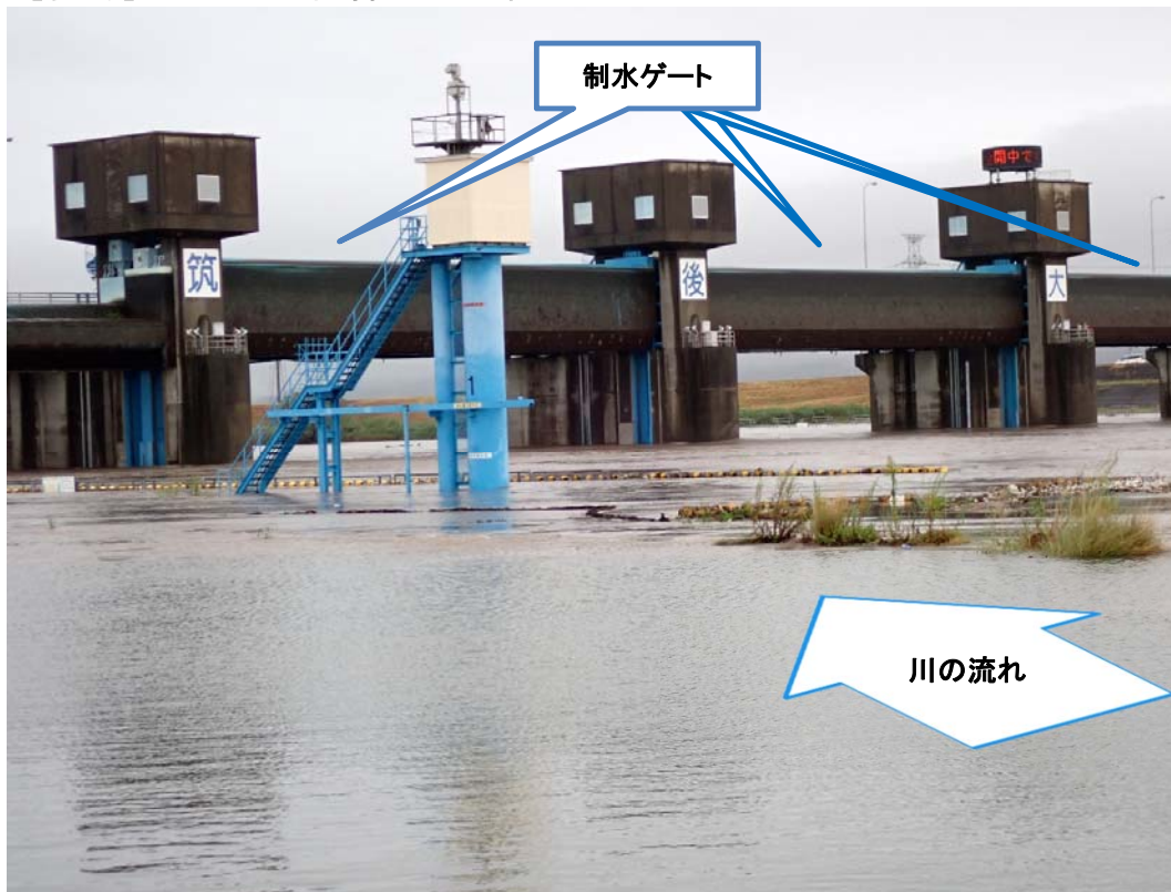
ゲート全開操作開始後の筑後大堰 (左岸上流側から筑後大堰を望む)
