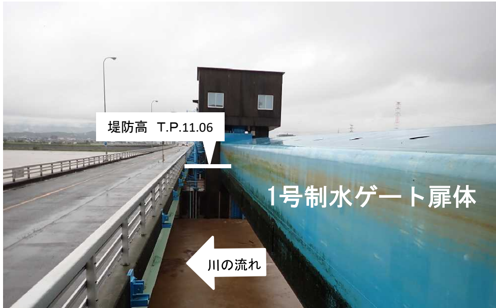
ゲート全開操作開始後の筑後大堰 (1号制水ゲートを左岸から右岸方向に望む)
