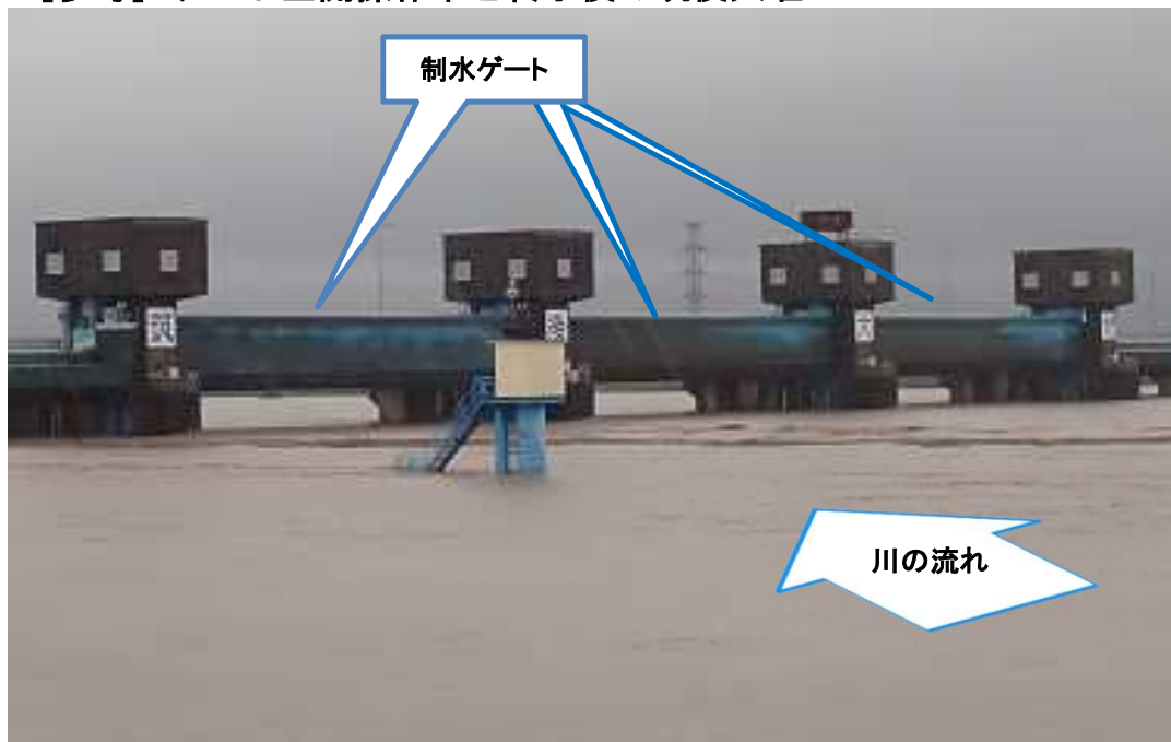
ゲート全開操作開始後の筑後大堰 (左岸上流側から筑後大堰を望む)
