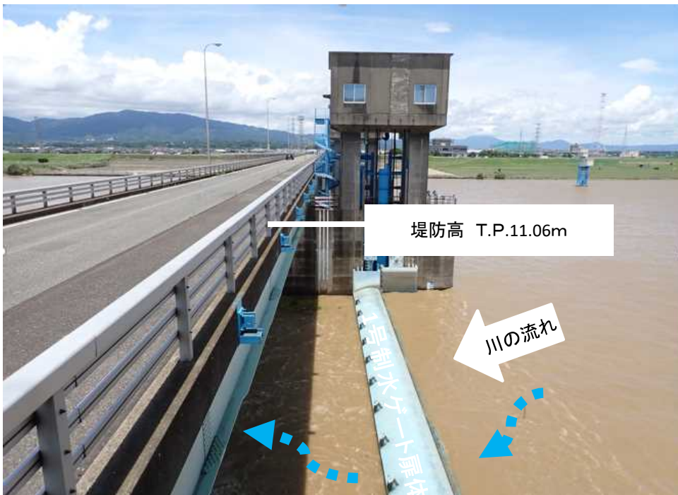
ゲート全開操作終了後の筑後大堰 (1号制水ゲートを左岸から右岸方向に望む)
